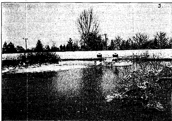
A szivattyútelep ellennyomó medencéje
